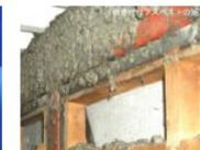
Ŝprucita Asbesto en konstruaĵo
