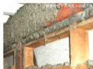
Ŝprucita Asbesto en konstruaĵo
