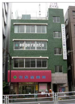
J E I 事務所 「エスペラント会館」 東京都新宿区
